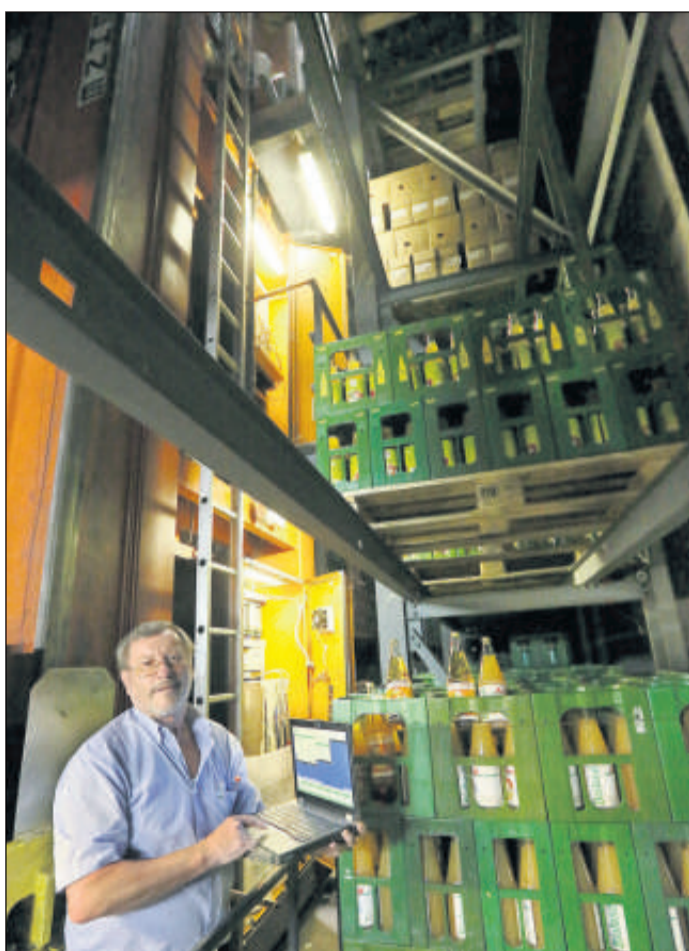
Das moderne Hochlager bei Jope Fruchtsäfte in Weinstadt betreut Eberhard Mayer noch heute. Er hat es seinerzeit für die Firma Birkel an selber Stelle mit aufgebaut. Fotos: Zürrn
